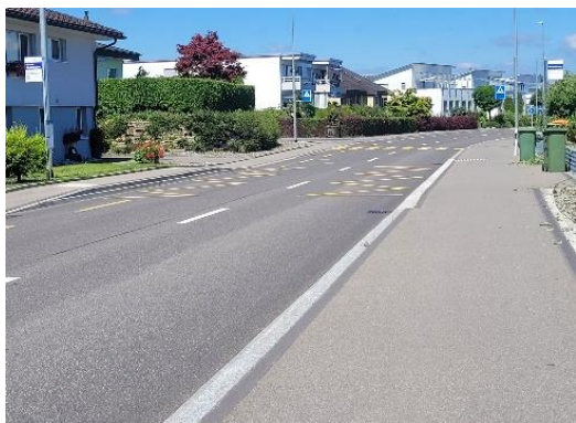
Abbildung 19: Bauliche Fahrbahnhaltestelle Haltestelle Buonas Neuhofstrasse; Quelle: Eigenaufnahme
